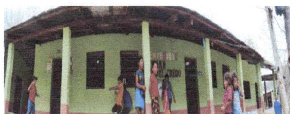
Foto 2: ESTRUCTURA DE TECHO. SUSTITUCIÓN DE ESTRUCTURA DE SOPORTE DE MADERA, POR METAL (DESMONTAJE Y MONTAJE).
