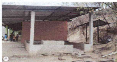
Foto 3: MURO DE PERIMETRAL (AULA). REPARACIÓN DE MURO PERIMETRAL DE BLOCK ( CONTINUACION DE MURO DE AULA BLOQUE III, CON REPELLO EN MURO INTERIOR Y EXTERIOR ).
