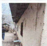
Foto1: CUBIERTA DE LÁMINA. SUSTITUCIÓN DE LÁMINA, POR LÁMINA TROQUELADA ALUZINC CALIBRE 26; (DESMONTAJE Y MONTAJE).
