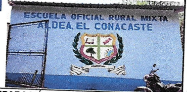
Foto 2: MUROS PERIMETRAL. REPARACIÓN DE PARED DE BLOCK EN AULA UBICADA EN LA ENTRADA DEL ESTABLECIMIENTO EDUCATIVO.
