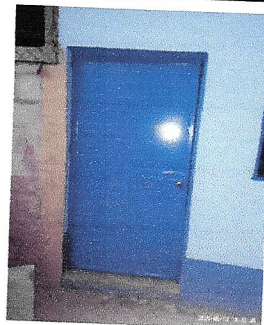
Foto 4: MANO DE OBRA ESPECIALIZADA (HERRERÍA). FABRICACIÓN E INSTALACIÓN DE PUERTA DE METAL EN AULA UBICADA EN LA ENTRADA DEL ESTABLECIMIENTO EDUCATIVO (1 X 2.10 MTS).
