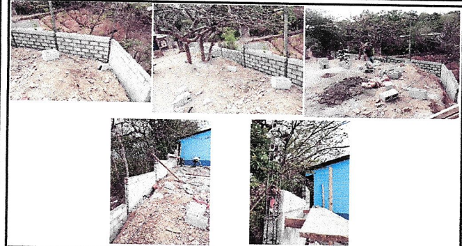
Foto1: MUROS PERIMETRAL. REPARACIÓN DE MURO PERIMETRAL DE BLOCK CON SOLERAS INTERMEDIAS Y COLUMNAS.
