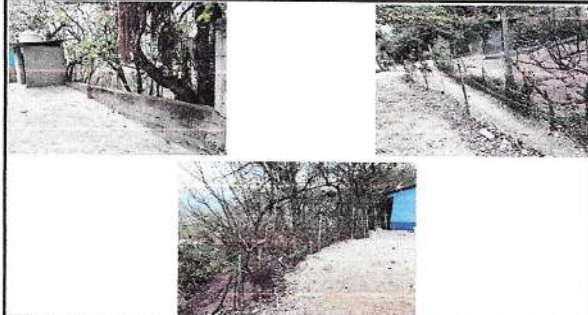
Foto1: MUROS PERIMETRAL. REPARACIÓN DE MURO PERIMETRAL DE BLOCK CON SOLERAS INTERMEDIAS Y COLUMNAS.
