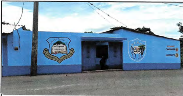
Foto1: PINTURA EN MURO EXTERIOR
