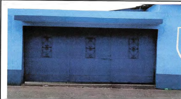
Foto 3: MANTENIMIENTO A PORTÓN DE METAL DE INGRESO
