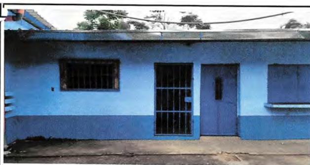
Foto 5: MANTENIMIENTO A ESTRUCTURA DE METAL DE PUERTAS DE AULAS
