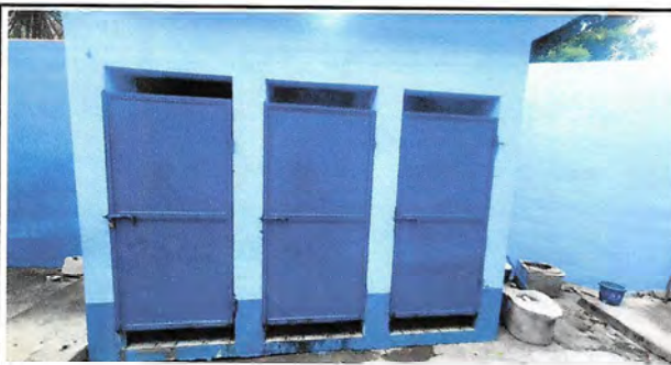
Foto 4: SUSTITUCIÓN DE PUERTAS DE METAL EN SERVICIOS SANITARIOS
