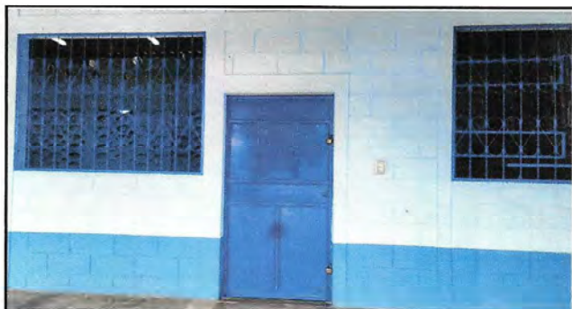
Foto 7: MANTENIMIENTO DE ESTRUCTURA DE METAL DE VENTANAS DE AULAS
