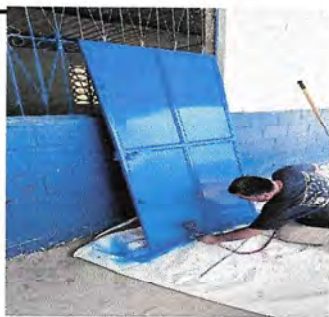
Foto 3: MANTENIMIENTO A PORTÓN DE METAL DE INGRESO
