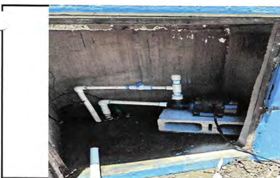
Foto 11: SUSTITUCIÓN DE BOMBA HIDRONEUMÁTICA POR BOMBA DE 1HP CON SUS ACCESORIOS
