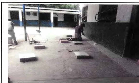
Foto 8: SUSTITUCIÓN DE PISO DE TORTA DE CONCRETO POR PISO CERÁMICO EN AULA 2da Y DIRECCIÓN
