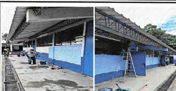
Foto 2: PINTURA EN INTERIOR
