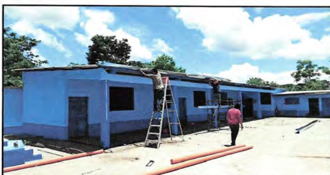
Foto 9: SUSTITUCIÓN DE CANAL DE METAL CON BAJADAS DE AGUA PLUVIAL
