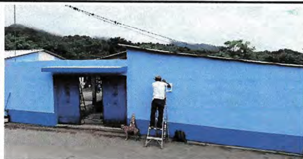
Foto1: PINTURA EN MURO EXTERIOR
