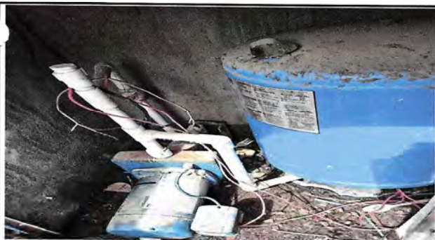
Foto 11: SUSTITUCIÓN DE BOMBA HIDRONEUMÁTICA POR BOMBA DE 1HP CON SUS ACCESORIOS
