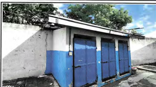
Foto 10: SUSTITUCIÓN DE ESTRUCTURA DE METAL POR LOSA EN SERVICIOS SANITARIOS / INSTALACIÓN DE DEPOSITO DE AGUA
