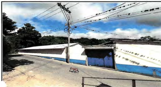
Foto1: PINTURA EN MURO EXTERIOR
