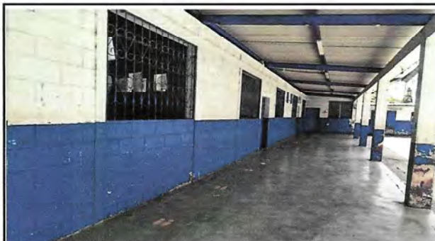
Foto 2: PINTURA EN INTERIOR
