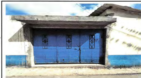
Foto 3: MANTENIMIENTO A PORTÓN DE METAL DE INGRESO
