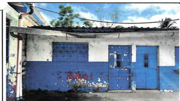
Foto 5: MANTENIMIENTO A ESTRUCTURA DE METAL DE PUERTAS DE AULAS
