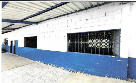
Foto 7: MANTENIMIENTO DE ESTRUCTURA DE METAL DE VENTANAS DE AULAS
