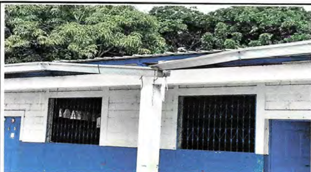
Foto 9: SUSTITUCIÓN DE CANAL DE METAL CON BAJADAS DE AGUA PLUVIAL
