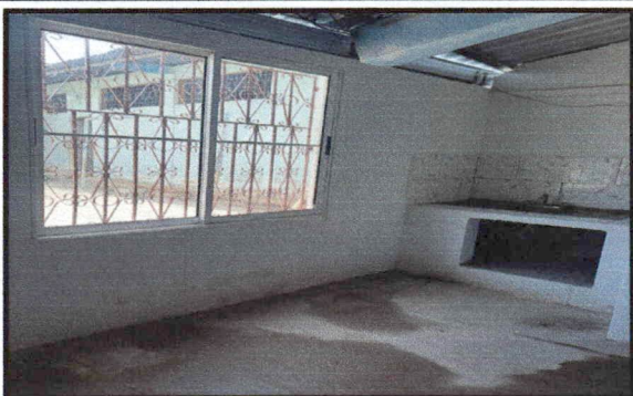
Foto 10 ESTRUCTURA DE TECHO
