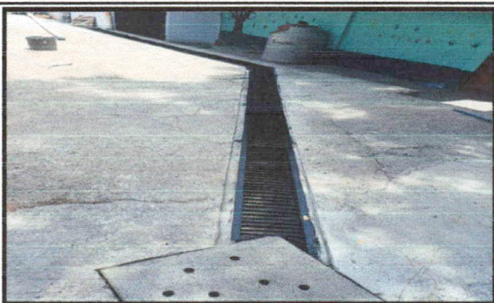
Foto 5: CUNETETA DE CONCRETO
