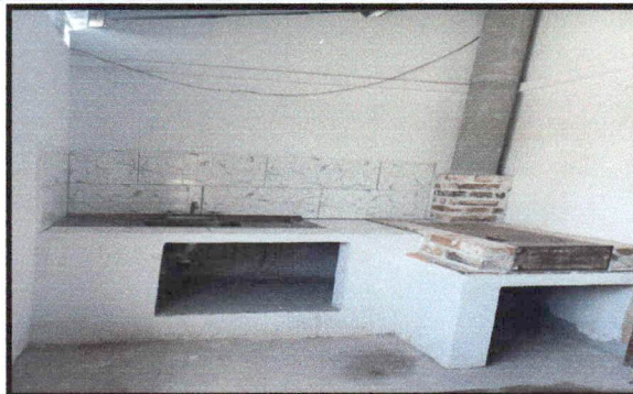
Foto 11 REPARACION DE COCINA
