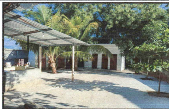
Foto 2: LOSA DE PATIO
