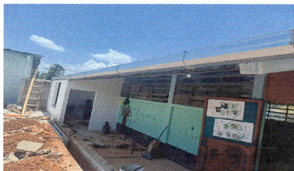
Foto 4: CANALES Y BAJADAS DE AGUA PLUVIAL
