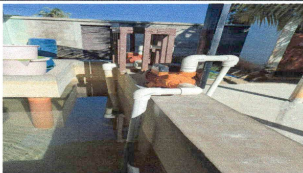
Foto 6: REPARACION Y MANTENIMIENTO DE DEPOSITO DE AGUA
