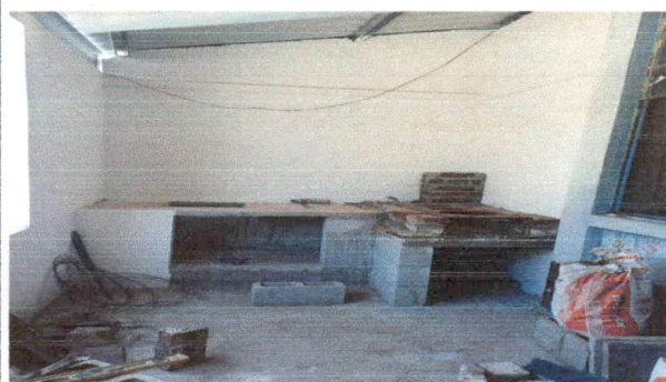
Foto 11 REPARACION DE COCINA
