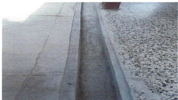
Foto 5: CUNETA DE CONCRETO
