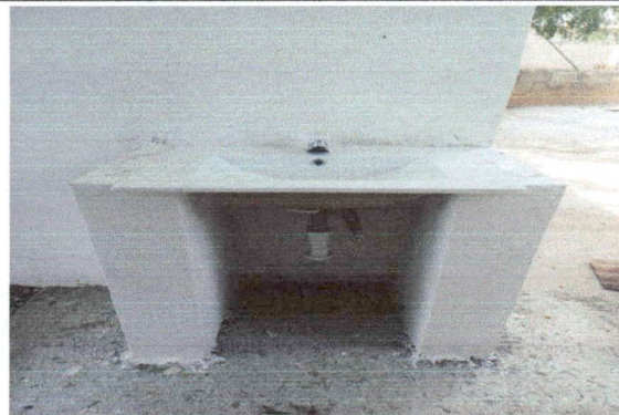
Foto 8 SUSTITUCION DE LAVAMANOS
