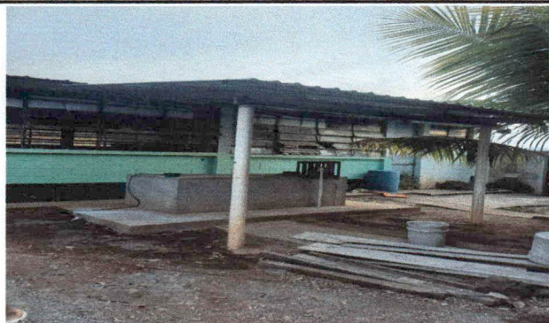
Foto 1: ESTRUCTURA DE TECHO
