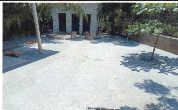
Foto 2: LOSA DE PATIO
