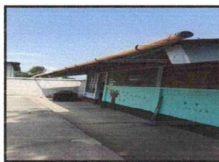
Foto 4: CANALES Y BAJADAS DE AGUA PLUVIAL
