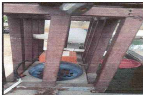
Foto 6: REPARACION Y MANTENIMIENTO DE DEPOSITOS DE AGUA
