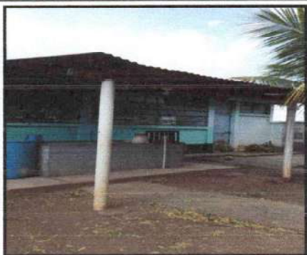
Foto 1: ESTRUCTURA DE TECHO
