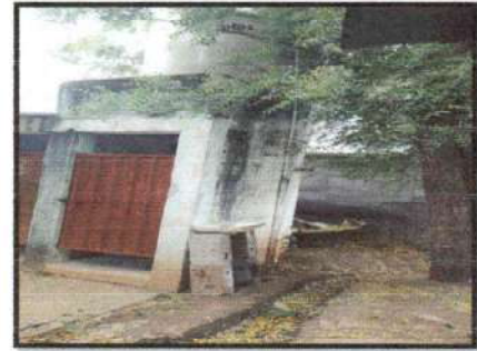
Foto 8: SUSTITUCION DE LAVAMANOS
