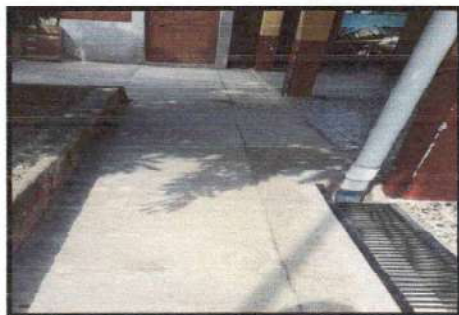
Foto 5: CUNETA DE CONCRETO
