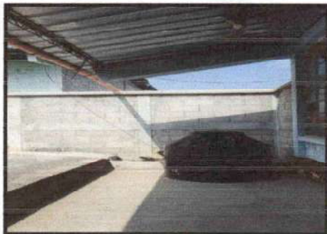
Foto 9: ESTRUCTURA DE TECHO
