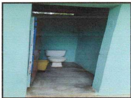
Foto 3: SERVICIOS SANITARIOS Y SUS ACCESORIOS, PISO
