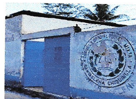
Foto 2: MANTENIMIENTO A PORTONES. MANTENIMIENTO A PORTON DE METAL DE ENTRADA PRINCIPAL (LIJADO, REPARADO Y CAMBIO DE CHAPA).
