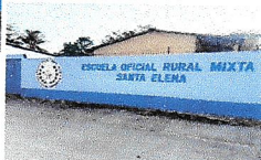
Foto 3: PINTURA EN MURO EXTERIOR. MANO DE OBRA ESPECIALIZADA (RESANE, ESCREPEO Y APLICACIÓN DE PINTURA EN MURO EXTERIOR DEL ESTABLECIMIENTO EDUCATIVO).
