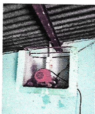
Foto 5: REPARACIÓN Y MANTENIMIENTO DE CISTERNAS /DEPÓSITOS DE AGUA. SUSTITUCIÓN DE BOMBA DE AGUA DE 1 HP, CON SUS ACCESORIOS E INSTALACIÓN.
