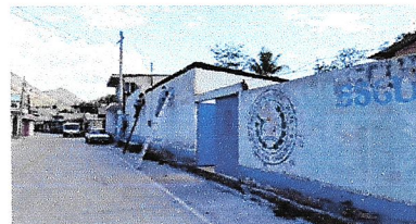
Foto 2: MANTENIMIENTO A PORTONES. MANTENIMIENTO A PORTON DE METAL DE ENTRADA PRINCIPAL (LIJADO, REPARADO Y CAMBIO DE CHAPA).
