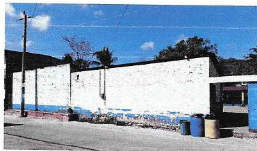
Foto 2: MANTENIMIENTO A PORTONES. MANTENIMIENTO A PORTON DE METAL DE ENTRADA PRINCIPAL (LIJADO, REPARADO Y CAMBIO DE CHAPA).
