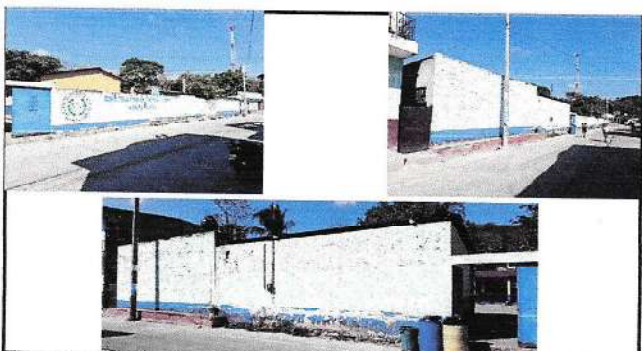
Foto 3: PINTURA EN MURO EXTERIOR. MANO DE OBRA ESPECIALIZADA (RESANE, ESCREPEO Y APLICACIÓN DE PINTURA EN MURO EXTERIOR DEL ESTABLECIMIENTO EDUCATIVO).
