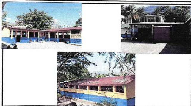
Foto 1: CUBIERTA DE LÁMINA. SUSTITUCIÓN DE LÁMINA POR LÁMINA ACANALADA CALIBRE 26, INSTALADA.
