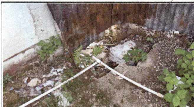
SUSTITUCIÓN DE TUBERÍAS
