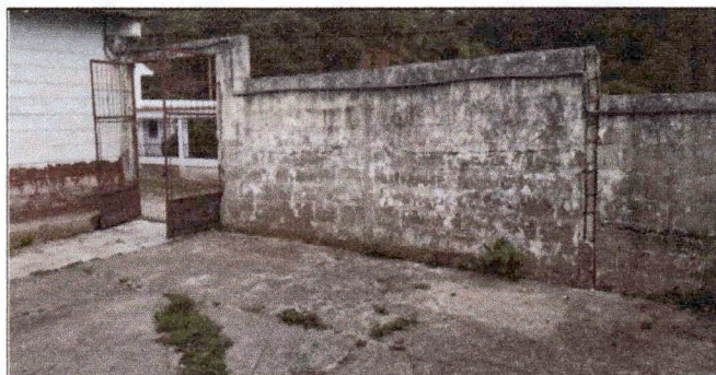
FABRICACIÓN E INSTALACIÓN PORTÓN DE METAL DE INGRESO A LA ESCUELA
