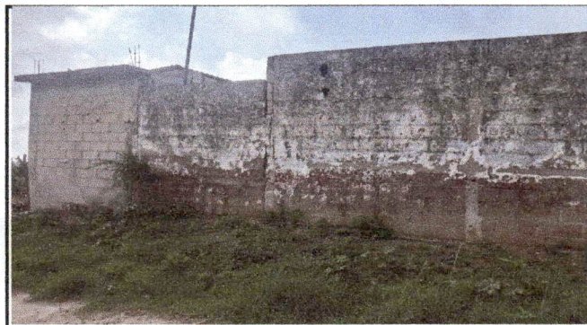
REPARACIÓN DE MURO PERIMETRAL DE BLOCK
