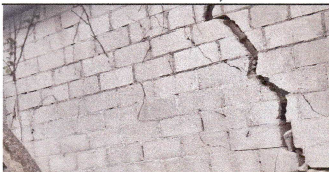
REPARACIÓN DE MURO PERIMETRAL DE BLOCK
