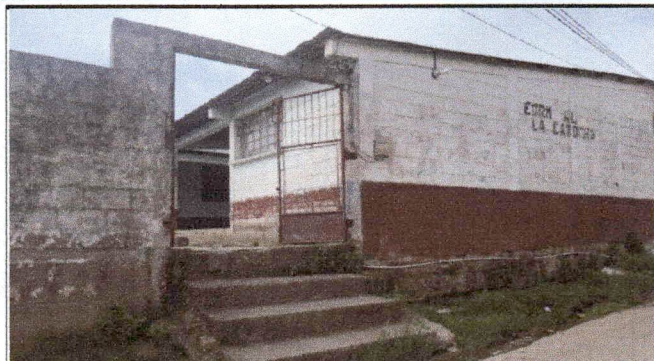
PINTURA EN EXTERIORES E INTERIORES
