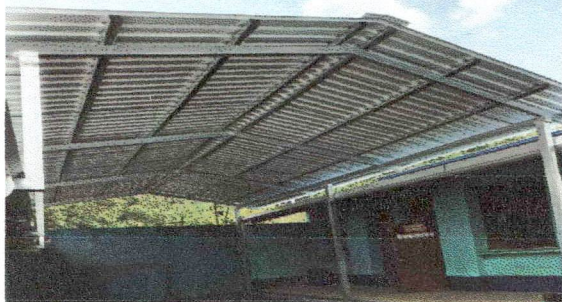
Foto1: SUSTITUCIÓN DE CUBIERTA DE LÁMINA
