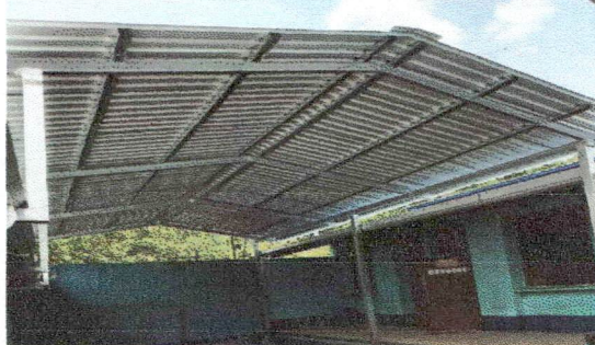
Foto 2: SUSTITUCIÓN DE ESTRUCTURA DE MADERA POR ESTRUCTURA DE METAL
