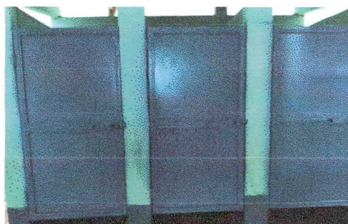
Foto 4: MANTENIMIENTO DE PUERTAS DE BAÑOS
