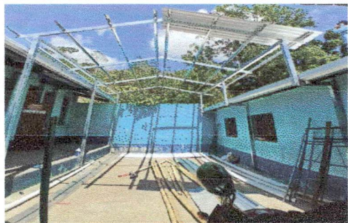
Foto 1: SUSTITUCIÓN DE CUBIERTA DE LÁMINA
