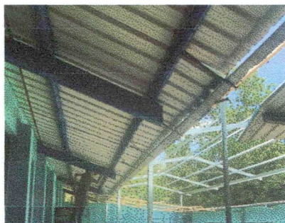
Foto 3: SUSTITUCIÓN DE CANAL Y BAJADAS DE AGUA PLUVIAL
