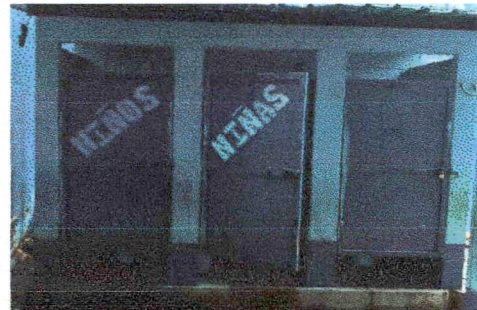
Foto 4: MANTENIMIENTO DE PUERTAS DE BAÑOS
