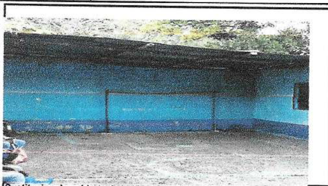
Sustitución de cubierta de lamina
