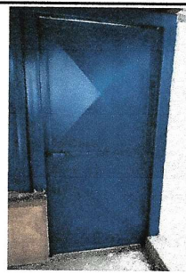
Foto 4: Sustitución de puerta de 0.87m. x 2.02m.
