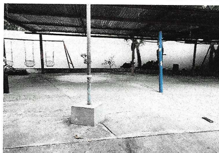
Foto 2: Reparación de muro perimetral de block.
