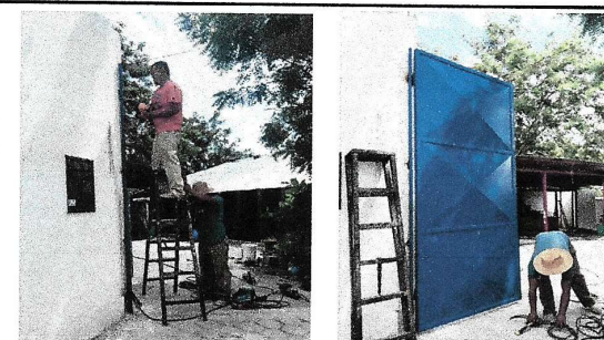
Foto 5: Sustitución de portón de metal de 2.90m. x 2.90m.
