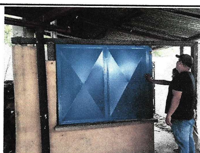
Foto 6: Sustitución de estructura de metal de ventana de 1.56m. x 1.30m.
