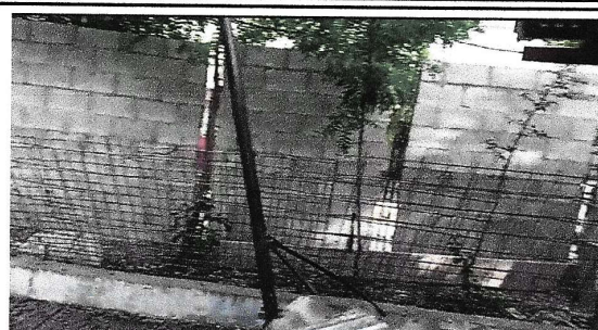
Foto 2: Reparación de muro perimetral de block.
