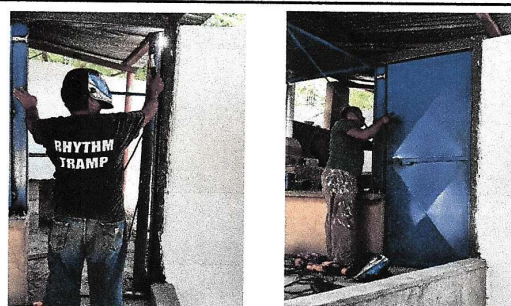
Foto 4: Sustitución de puerta de 0.87m. x 2.02m.
