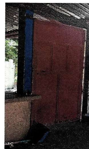
Foto 4: Sustitución de puerta de 0.87m. x 2.02m.
