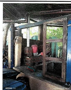
Foto 6: Sustitución de estructura de metal de ventana de 1.56m. x 1.30m.
