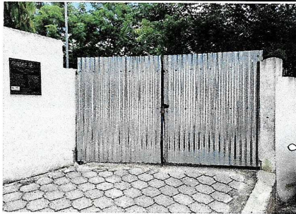
Foto 5: Sustitución de portón de metal de 2.90m. x 2.90m.
