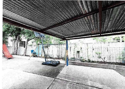
Foto 2: Reparación de muro perimetral de block.
