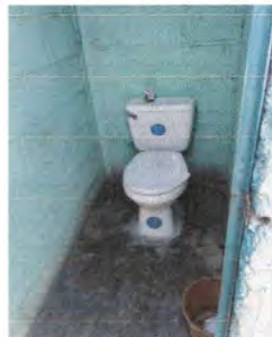
Foto 2: Sustitución de baños
