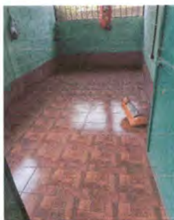
Foto 3: Sustitución de Piso Dirección
