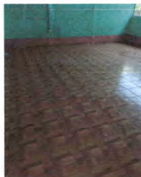
Foto 4: Sustitución Piso Aula
