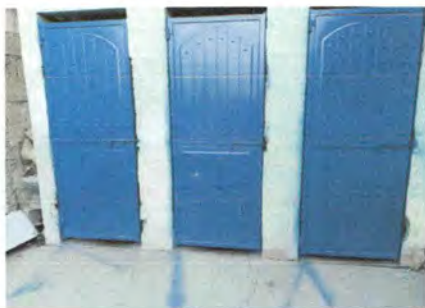
Foto 5: Sustitución Puertas de baño
