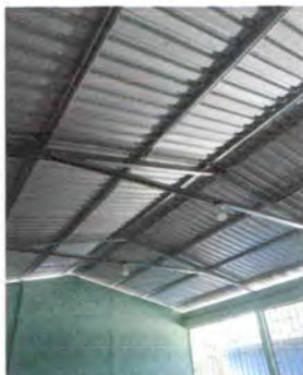
Foto1: Sustitución de techo y alumbrado eléctrico
