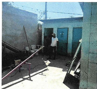
Foto 1: sustrucción de Puertas de baño
