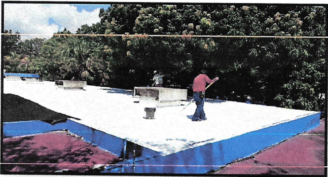
Foto 5: Finalizando los cinco módulos impermeabilizados del área de primero básico.
