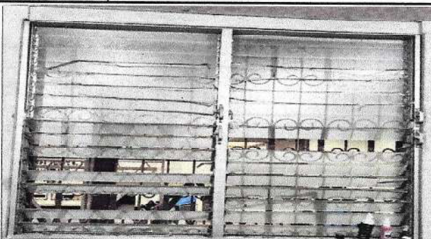
Foto 2: Sustitución de ventana en mal estado por ventana PVC
