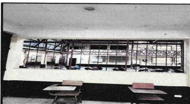
Foto 6: Instalación de ventanas PVC
