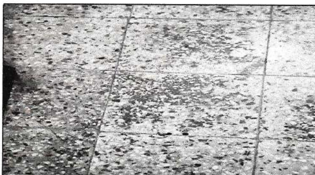
Foto 4: Sustitución de piso en mal estado por piso cerámico
