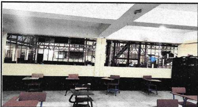
Foto 5: Instalación de ventanas PVC
