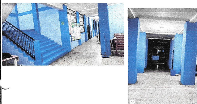
Foto1: PINTURA EN MUROS EXTERIORES E INTERIORES DE AULAS DEL ESTABLECIMIENTO EDUCATIVO (DE LOS 3 NIVELES).
