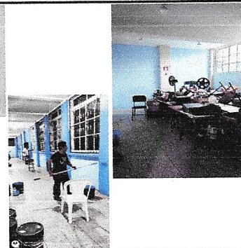
Foto 2: PINTURA EN MUROS EXTERIORES E INTERIORES DE AULAS DEL ESTABLECIMIENTO EDUCATIVO (DE LOS 3 NIVELES).
