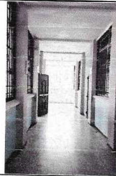
Foto 2: PINTURA EN MUROS EXTERIORES E INTERIORES DE AULAS DEL ESTABLECIMIENTO EDUCATIVO (DE LOS 3 NIVELES).
