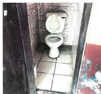
Foto 4: SUSTITUCIÓN DE 7 SANITARIOS
