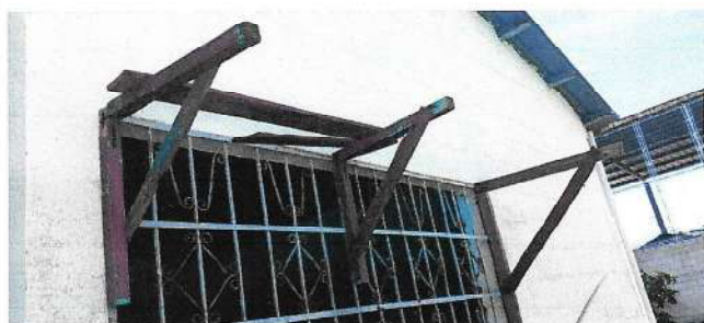
Foto 3: SUSTITUCIÓN VENTANA DE PVC.
