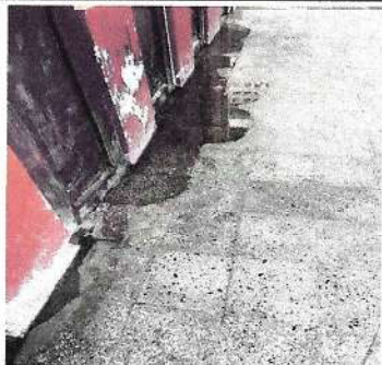
Foto 3: SUSTITUCIÓN DE DRENAJE
