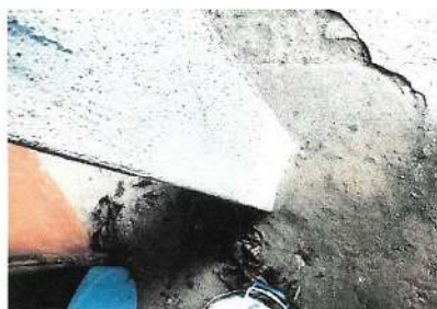
Foto 6: REPARACIÓN DE AGUJERO (HOYO) AGUA FLUVIAL
