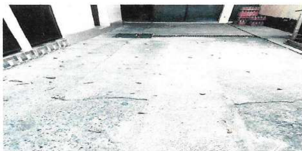
Foto 5: REPARACIÓN CAJA CON SIFÓN.
