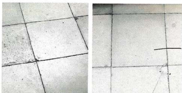
Foto 5: SUTITUCIÓN DE PISO
