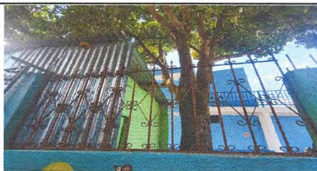
Foto 4: MANTENIMIENTO DE BALCONES , PINTURA DE BALCONES
