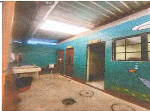
Foto 2: CAMBIO DE SANITARIOS , CAMBIO DE PISO DE LOS BAÑOS
