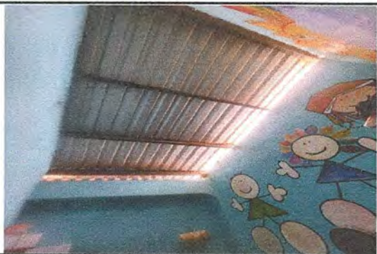
Foto1: INSTALACION ELECTRICA DIRECCION
