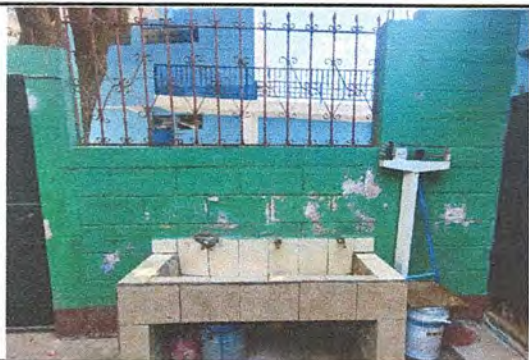
Foto 3: REMOZAMIENTO DE PINTURA , INSTALACION AZULEJO
