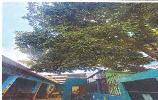
Foto 5: TECHADO DEL PATIO DE LA ESCUELA
