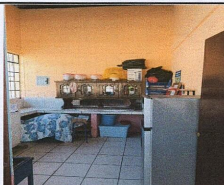
Foto 4: Remozamiento y ampliación de cocina
