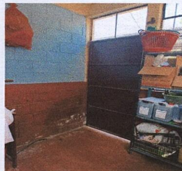
Foto 6. sellado de puerta y cambio de piso
