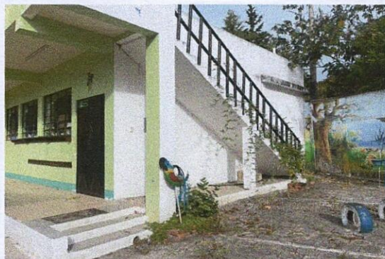
Foto 2: Colocación de block y puerta en área de gradas
