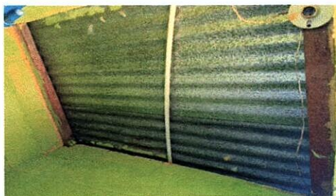
Foto 6: cambio de techo en el area de sanitarios
