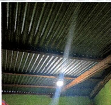
Foto 3: cambio de estructura techo del área de cocina
