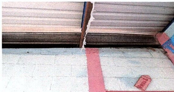
Foto 1: Levantado de altura de pared y cambio de láminas, aula y dirección
