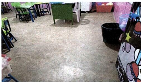
Foto 5: cambio de piso de torta de cemento de las aulas
