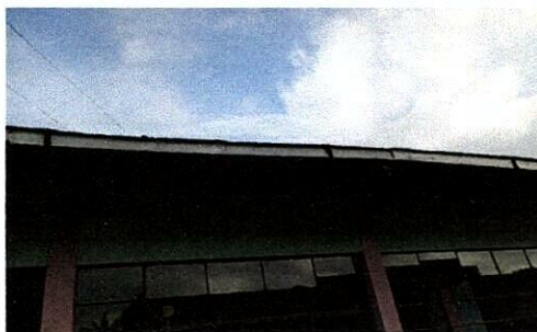
Foto 2: Cambio de canales y bajada de agua
