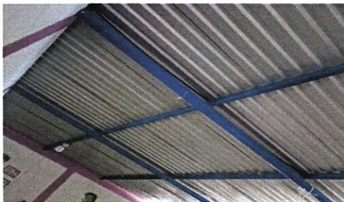
Foto 3: implementación de lamiluz para mejorar iluminación del aula.
