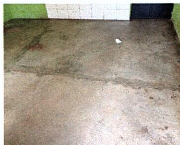
Foto 4: cambio de piso del área de cocina
