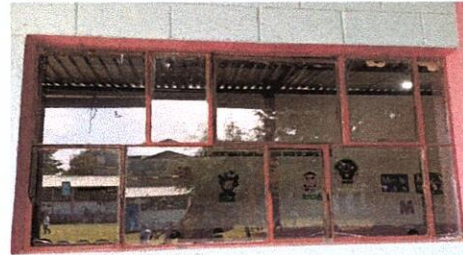
Foto 2: cambio de ventanal para mejorar la ventilación del aula
