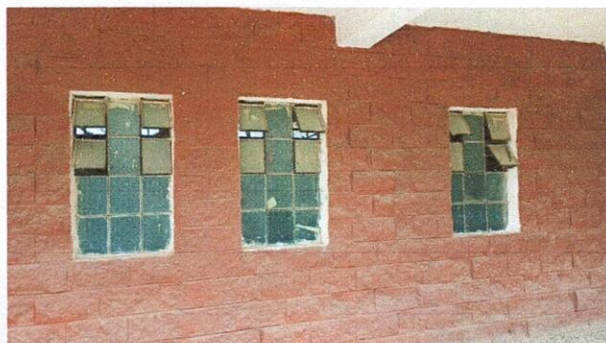
Foto 5: ventanas sin balcones
