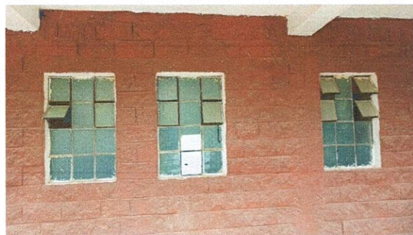
Foto 6: ventanas sin balcones
