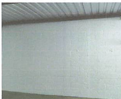
Foto 3: Impermeabilización de paredes
