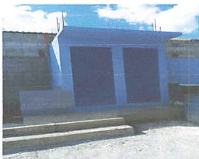
Foto 5: Implementación de dos sanitarios y lavamanos fundido
