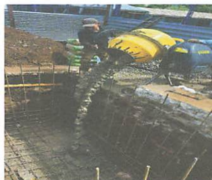
Foto 4: Implementación de cisterna
