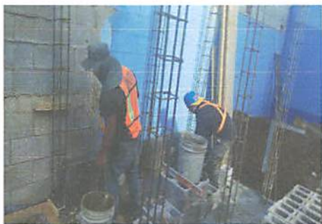
Foto 5: Implementación de dos sanitarios y lavamanos fundido
