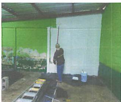
Foto 3: Impermeabilización de paredes
