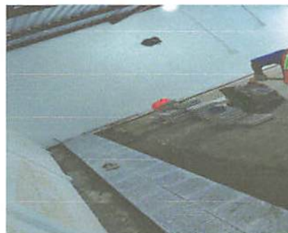
Foto 6: Sustitución de piso torta por piso granito
