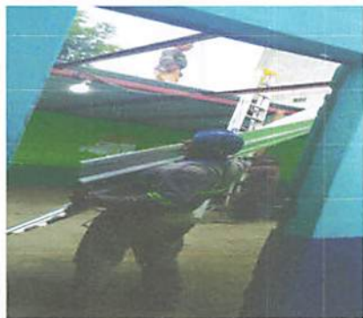
Foto1: Sustitución de lámina por lámina troquelada
