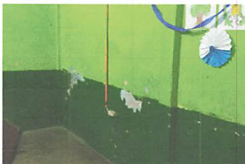
Foto 3: Impermeabilización de paredes
