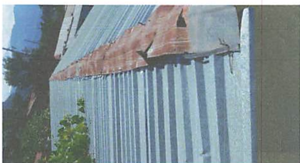
Foto 1: Sustrucción de lámina por lámina troquelada
