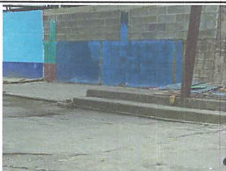
Foto 5: Implementación de dos sanitarios y lavamanos fundido
