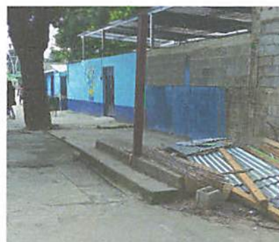
Foto 4: Implementación de cisterna
