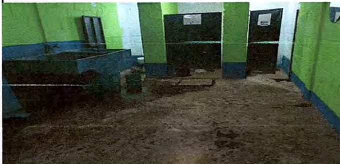
Foto 4: PUERTAS, PISO Y CAMBIO DE SERVICIOS SANITARIOS
