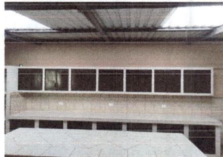
Foto 4: Ventana cerrada ya que se elaboraron los gabinetes.
