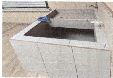
Foto 2: Culminacion de pila
