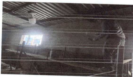
Foto 3: Trabajo previo a la colocación de azulejo
