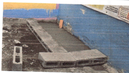
Foto 6: Elaboracion de caseta para gas
