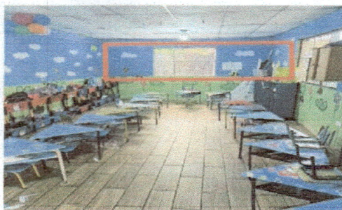
Foto 3: en el espacio dentro del recuadro se colocará azulejo.
