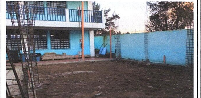
Foto 6: Una vez que este levantado se necesita el acabado y puertas.
