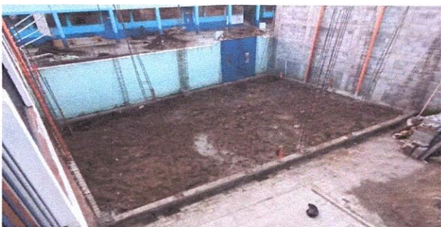
Foto 5: Una vez que esté las paredes se necesita el techado
