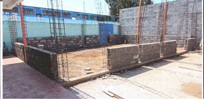
Foto 2: Necesidad de fundir las columnas verticales
