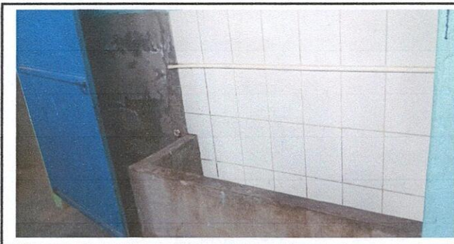
Foto 12: Reparación del minihitorio en el baño de varones.
