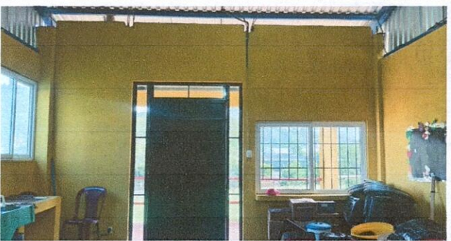
Foto 4: Completar pared del techo de frente y detras, colocación de persiana.
