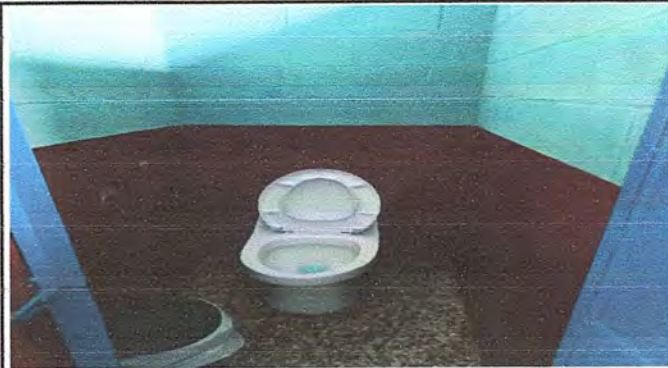
Foto 4: Colocación de azulejo en sanitarios (Reparación o sustitución de azulejo)
