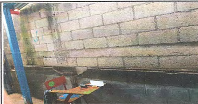
Foto 6: Completación de muros (Cerco o muro perimetral)
