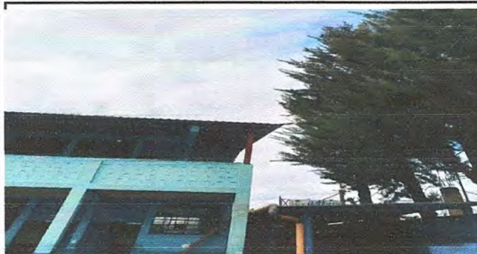
Foto 3: Instalacion de lamparas de iluminacion externa (Reparación de sistema eléctrico)
