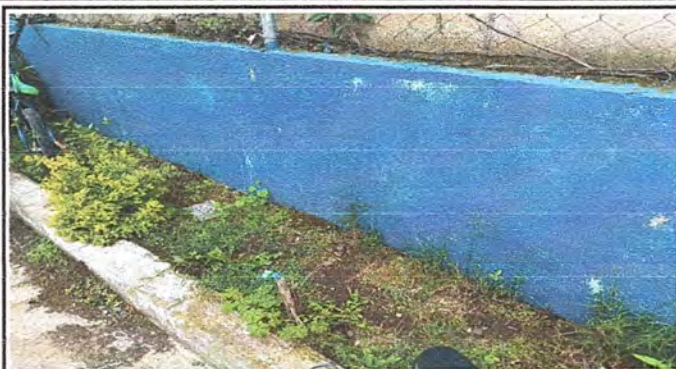
Foto 1: Construcción de pila de tres lavaderos (Reparación o sustitución de área de cocina)
