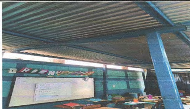
Foto 2: Instalacion de sistema electrico en espacios (Reparación de sistema eléctrico)
