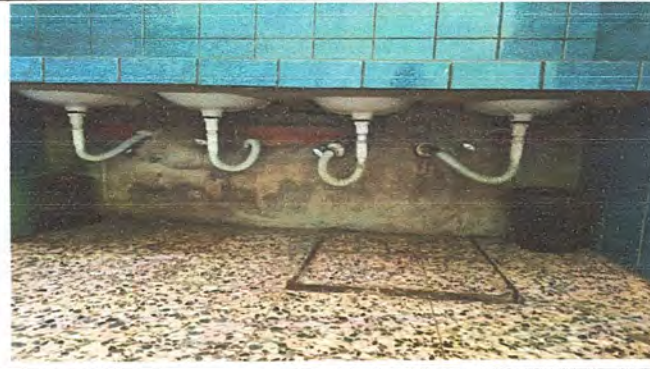
Foto 2: Sustrucción de llaves de abasto y magueras (Servicios sanitarios y accesorios)
