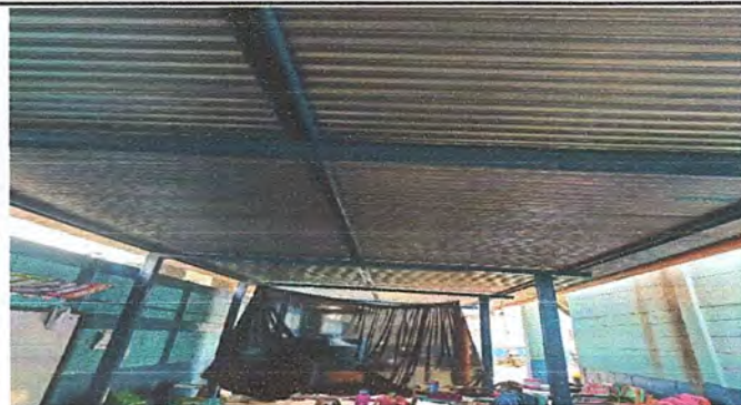
Foto1: Instalacion de sistema electrico en espacios (Reparación de sistema eléctrico)
