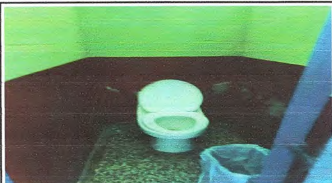
Foto 3: Colocación de azulejo en sanitarios (Reparación o sustitución de azulejo)
