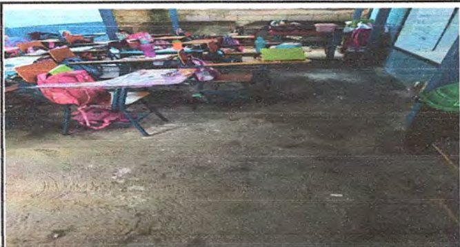
Foto 3: Colocación de piso de granito en espacio techado (Piso)
