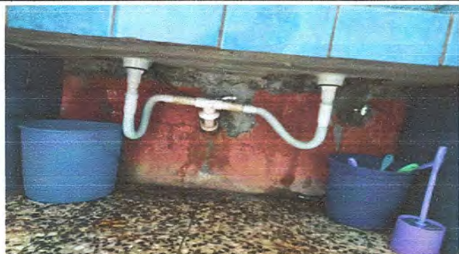
Foto 1: Sustrucción de llaves de abasto y magueras (Servicios sanitarios y accesorios)
