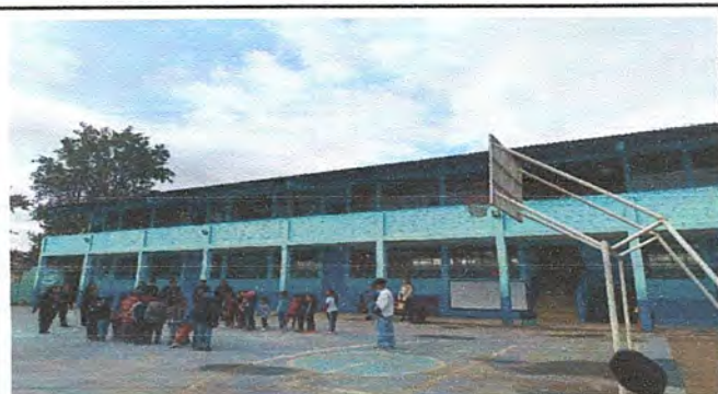
Foto 5: Pintura en muros interior y exterior
