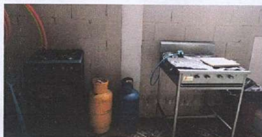
Foto 3: Implementación de casita para gas.
