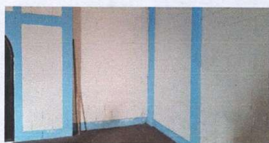
Foto 6: Levantado de muro tabique en bodega
