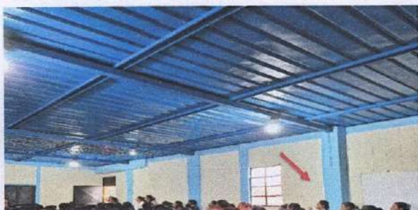
Foto 1: Ampliación de ventana del salón de usos múltiples.
