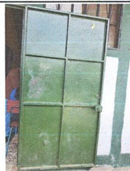
Foto 12: mantenimiento correctivo de puertas por deterioro
