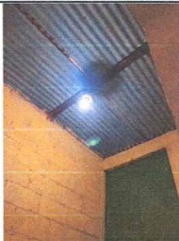
Foto 7: mantenimiento de techado por goteos de lluvias
