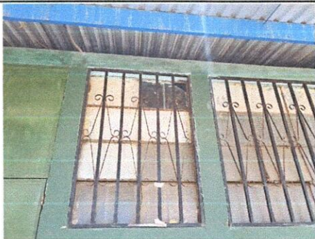
Foto 9: mantenimiento de balcones y ventanas
