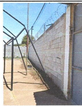
Foto 4: mantenimiento en paredes, aplicacion de cernido
