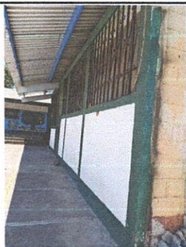
Foto 3: mantenimiento de paredes en pintura de paredes
