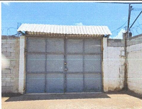
Foto 1: mantenimiento de porton de ingreso al instituto.
