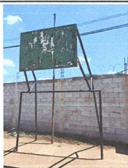
Foto 5: mantenimiento de porterias y canasta aplicacion de pintura.
