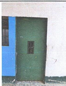
Foto 11: mantenimiento en pintura de puertas.
