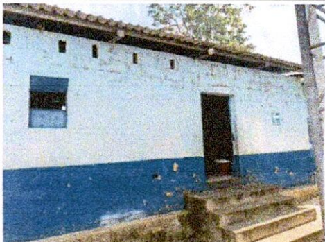
Foto 1: SUSTITUCIÓN DE PINTURA EN COCINA EN MUROS INTERIORES Y EXTERIORES.
