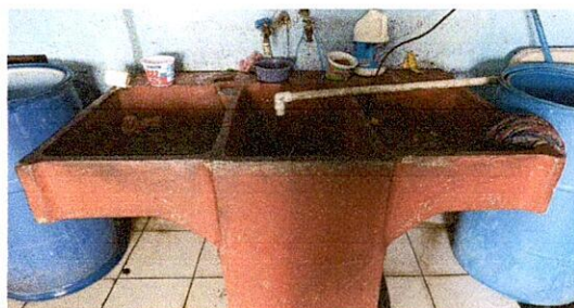
Foto 6: SUSTITUCION DE PILA POR FUGAS E IMPLEMENTACION POR PILA ARTESANAL
