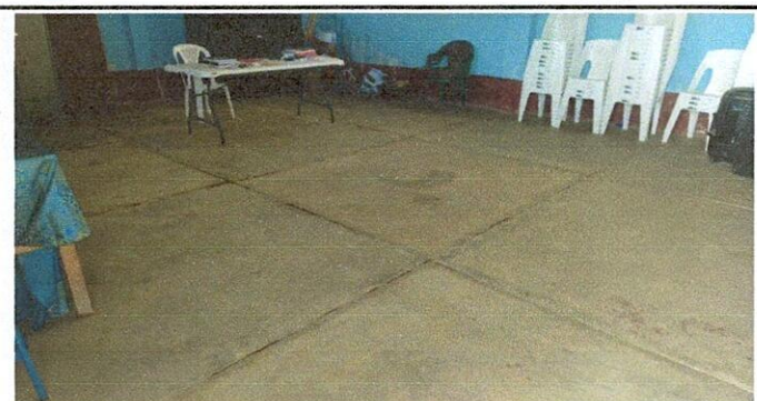
Foto 5: Piso de concreto en mal estado y deteriorado por el tiempo, se necesita piso antideslizante para darle mantenimiento y evitar más su desgaste.
