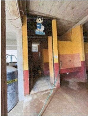
Foto 1: Sustitucion y colocacion de 2 puertas de 280 cm de alto por 90 cm de ancho.
