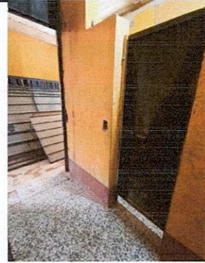
Foto 2: Sustitución de 5 puertas de baños de 165 cm de alto por 60 cm de ancho.
