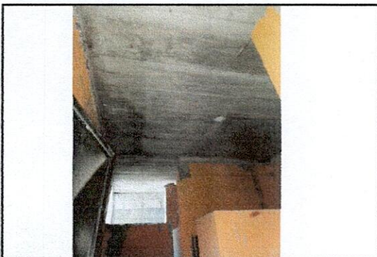
Foto 3: Cernido de 48 mts cuadrados de cielo de baños y corredor.
