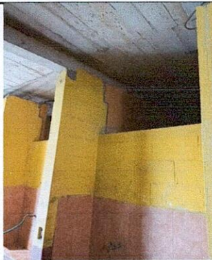
Foto 3: Instalacion de Seis ventanas para baños de 122 cm de largo por 80 cm de ancho.
