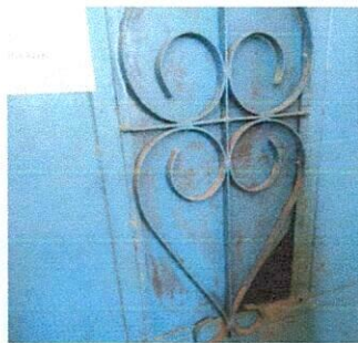
Foto 5: sustitución de chapa
