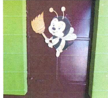
Foto 4: chapas en mal estado se necesita sustitucion de chapa
