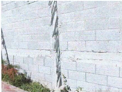
Foto 3: pintura en paredes
