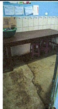
Foto 2: Mantenimiento de área de cocina.
