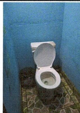
Foto 4: Mantenimiento de paredes del baño por humedad.
