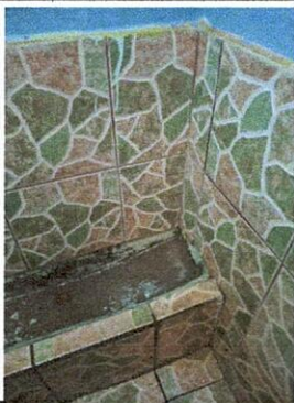
Foto 5: Mantenimiento de mingitorios en el área de sanitarios para niños.
