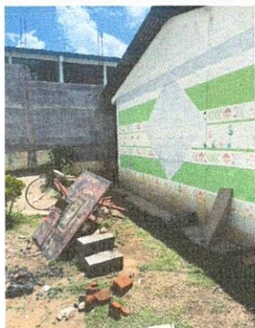
Foto1: Demolición de concreto viejo para su sustitución por deterioro
