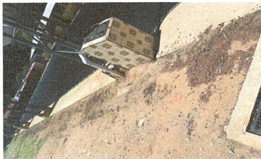
Foto 5: Fundicion de cuneta y demolición de concreto viejo para su sustitución por deterioro
