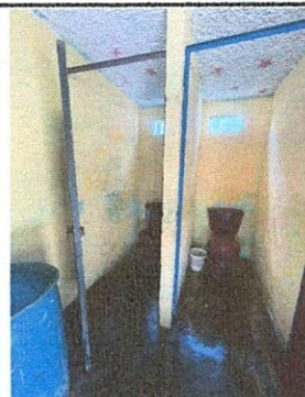
Foto 4: sustitucion de sanitarios, colocacion de zaulejo y pintado de cielo de baños
